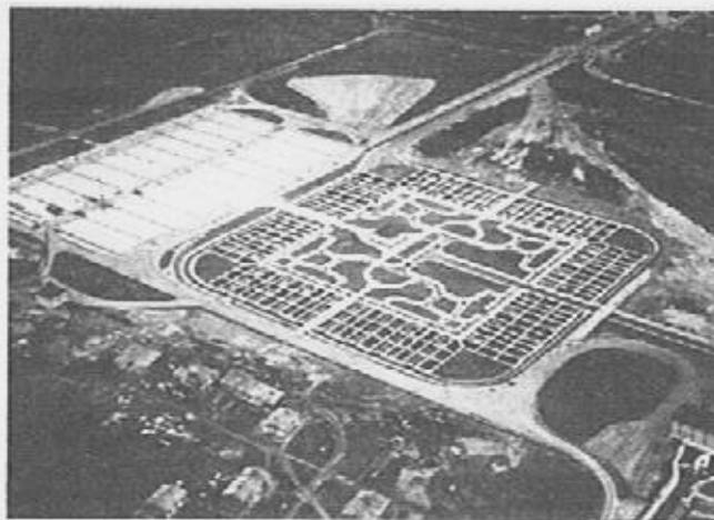
Fig. 4) Impianto di depurazione della Città di Monaco di Baviera, costituito interamente di fosse Imhoff, 1925
