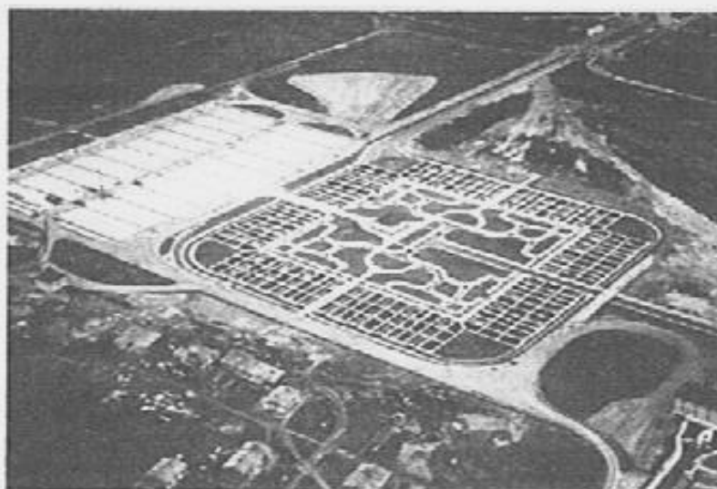
Fig. 4) Impianto di depurazione della Città di Monaco di Baviera, costituito interamente di fosse Imhoff, 1925
